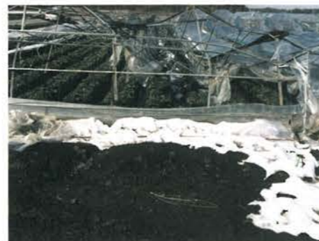
▲ 雪害対策 現地調査
